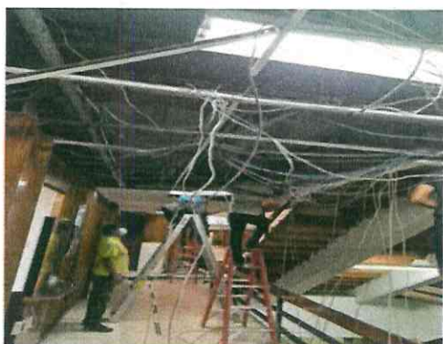
Reestructuración de cableado y cambio de cielo falso, primer nivel y sótano
