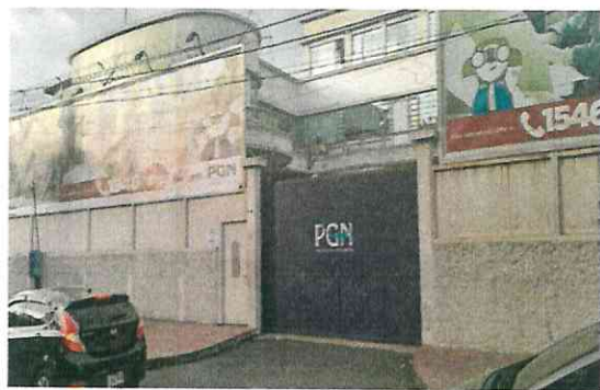
Nueva instalación de Alba Keneth
