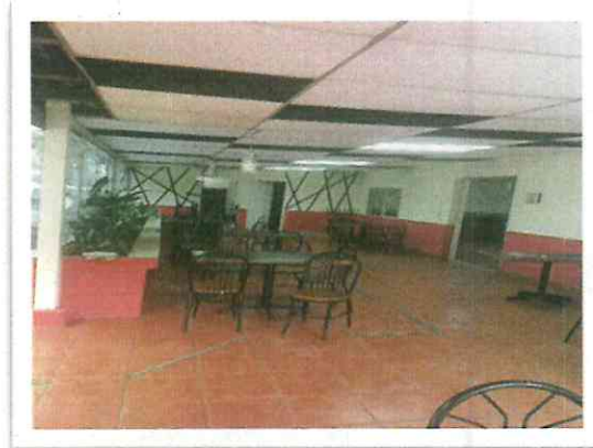
Mantenimiento y pintura a cafetería
