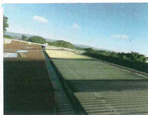
Cambio de láminas transparentes de policarbonato
