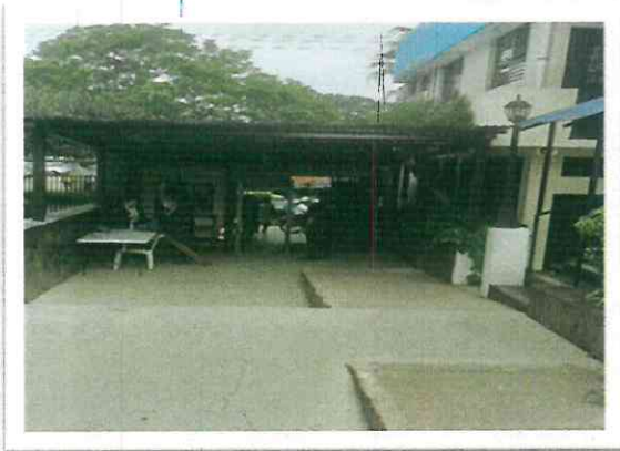
Ampliación de garita peatonal
