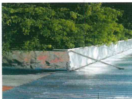
Cambio de láminas y limpieza de canales en la PNA
