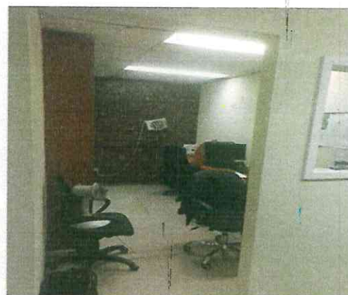
Remodelación Área Familia y Jurisdicción Voluntaria
