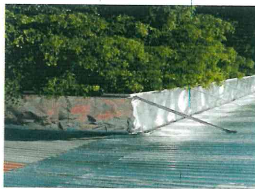
Cambio de láminas y limpieza de canales en PNA
