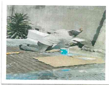
Delegación Regional en el departamento Santa Rosa, Cambio de lámina e impermeabilización
