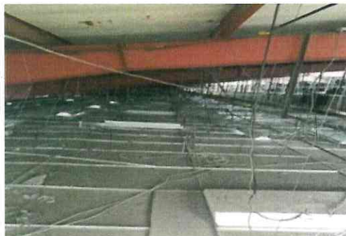
Mantenimiento de la estructura del Edificio Central
