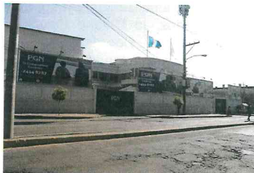
Nueva instalación de Alba Keneth
