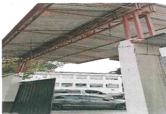
Ingreso al Parqueo A
